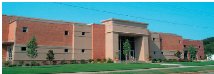
Bâtiment de l'Eglise Collège à Searcy (USA)
